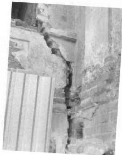
**Фото 26.** Состояние эркера с восточной стороны, глубокая трещина в кирпичной кладке. Ноябрь 2014 г./ **Фото 27.**
