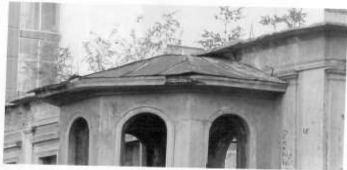
**Фото 24.** Состояние эркера с западной и юго-западной стороны, трещины в средней и верхней части эркера. **Фото 25 .**
