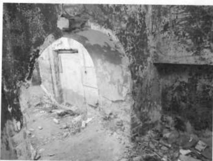
Фото 32. Фрагменты внутреннего пространства эркера (см. виды на планах), состояние стен, сводчатого потолка.
